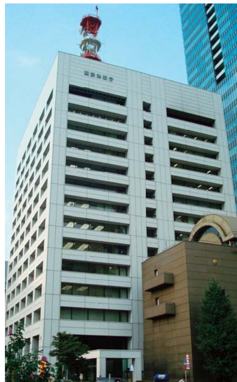
東京消防庁大手町本庁舎
